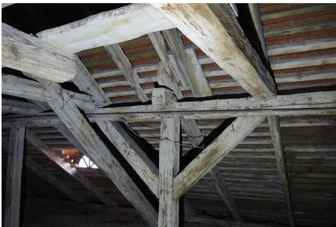
Fot. 25,26. Elementy oryginalnej więźby dachowej nad stajnią wschodnią – widoczna obróbka drewna i ciesielskie znaki montażowe.
