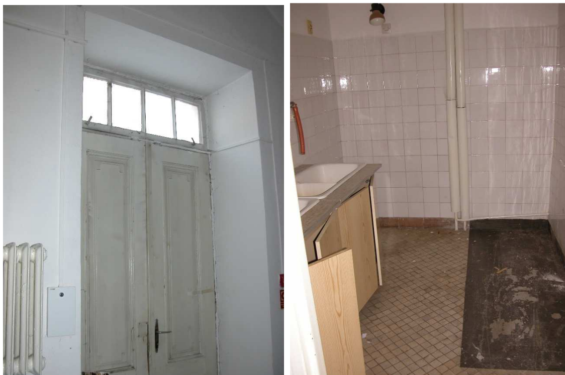
Fot. 19. Drzwi główne wejściowe widoczne z hallu w ryzalicie centralnym.
