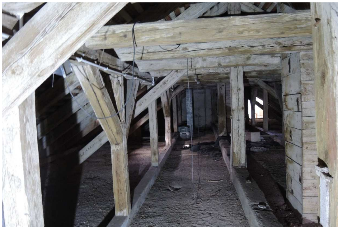
Fot. 24. Oryginalna więźba dachowa nad stajnią wschodnią.
