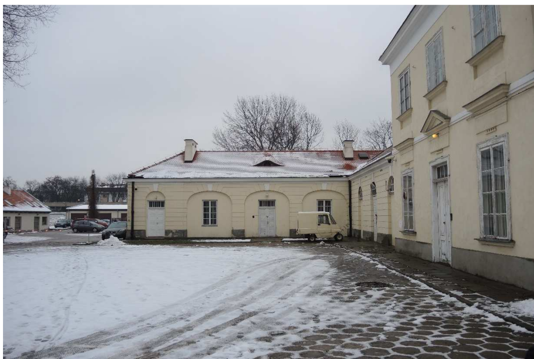
Fot. 2. Elewacja wewnętrzna wozowni wschodniej od strony dziedzińca – widoczne łuki koszowe dawnych wjazdów, po prawej – elewacja ryzalitu o tynkach gładkich i detalach nad i pod - okiennych.
