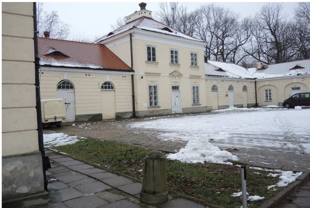
Fot. 1. Elewacja północna – frontowa widok ogólny dziedzińca od strony wjazdu.
