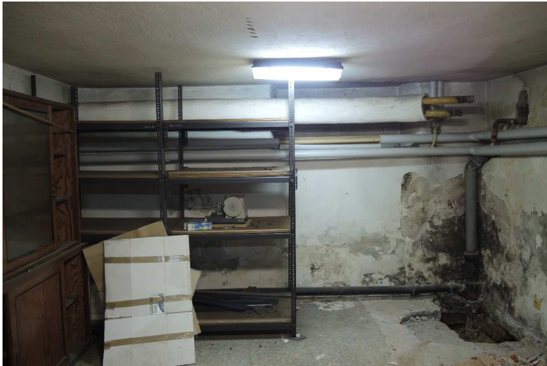
Fot. 29. Widok ogólny piwnicy w części zachodniej.
