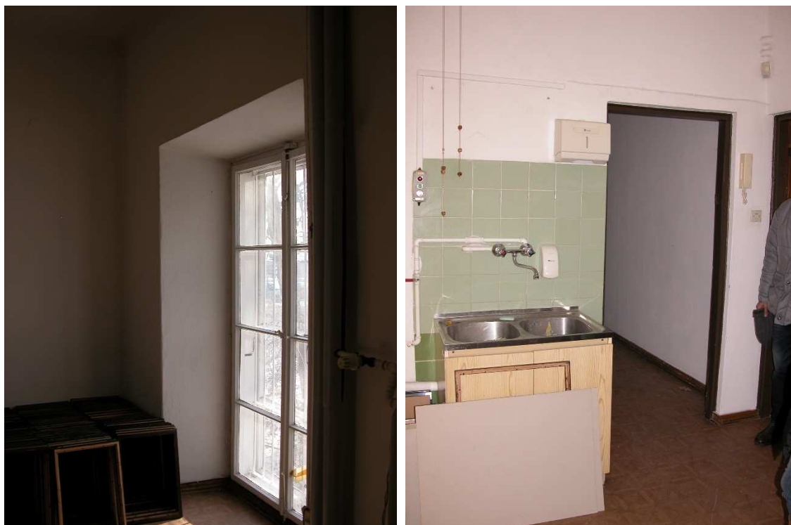
Fot. 17,18. Pomieszczenia na podwyższonym poziomie parteru – strop w poziomie parapetu, sposób zagospodarowania pracowni naukowych Muzeum Narodowego.
