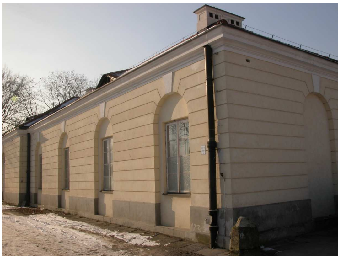
Fot. 5. Elewacja boczna wschodnia – fragment.
