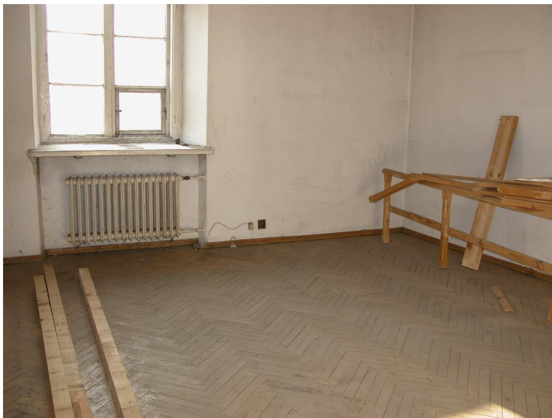
Fot. 23. Pokój mieszkania na piętrze.
