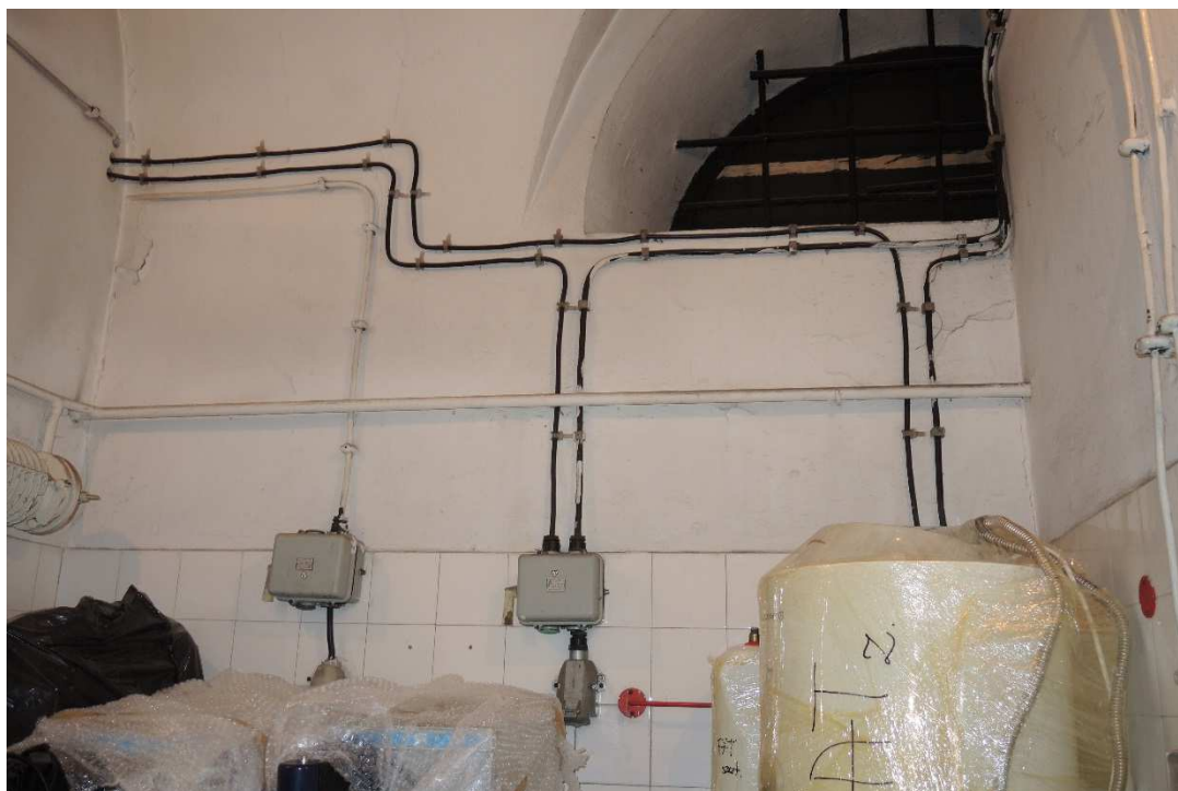
Fot. 11. Stan ogólny pomieszczeń urządzonych przez podział w d. stajni wschodniej.
