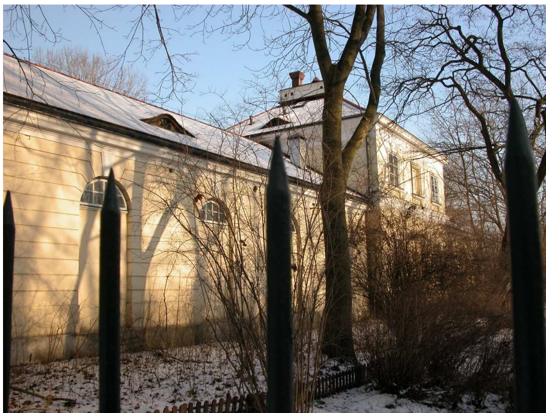
Fot. 3,4. Elewacja południowa – widoczne gładkie blendy, wysokie okna półlukowe stajni oraz pod gzymsem otwory d. systemu wentylacji stajni. W ryzalicie tynk gładki i blendy w centralnej osi okiennej.
