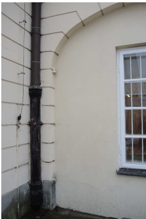
Fot. 6. Elewacja wschodnia wozowni zachodniej – widoczne relikty zawiasów wrót.
