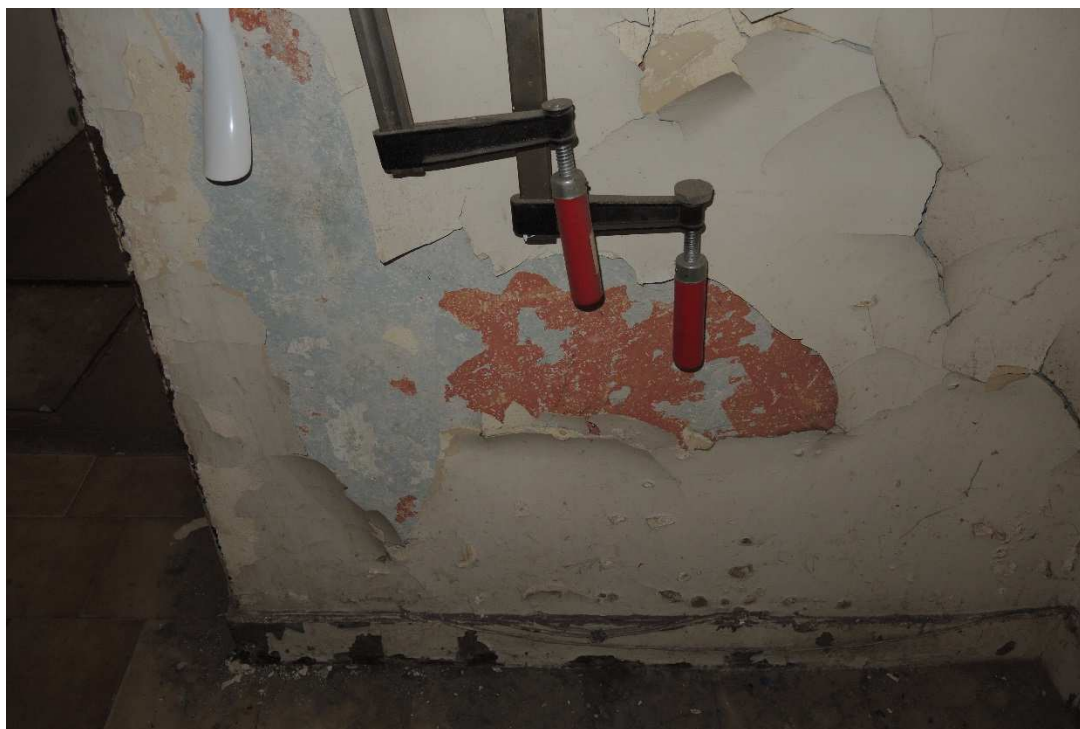
Fot. 12. Stan wypraw malarskich ścian w d. wozowni wschodniej. Naturalna odkrywka koloru.
