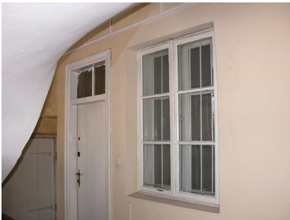
Fot. 21. Klatka na piętrze – wewnętrzne okno i drzwi z naświetlem.
